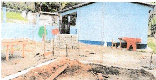
Foto 1: Mejoramiento de cocina tipo portico
