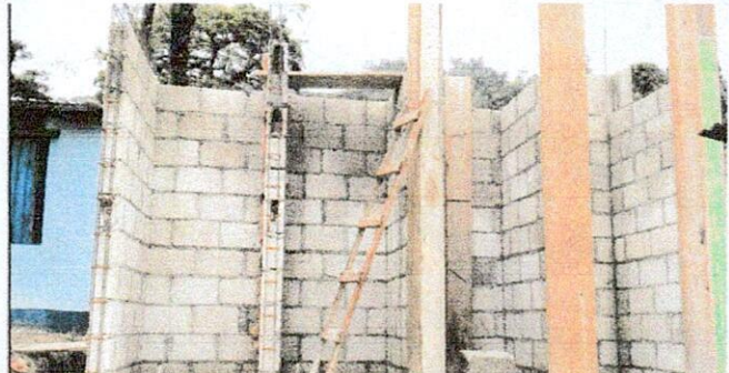
Foto 4: Mejoramiento de sanitarios y migitorio con pared de block
