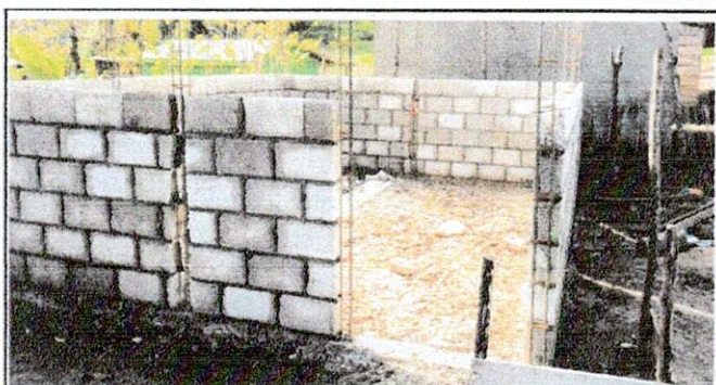
Foto 3: Mejoramiento de cocina tipo portico
