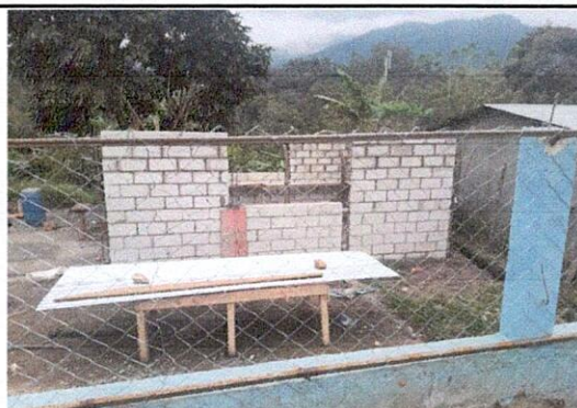
Foto 4: Mejoramiento de cocina tipo portico
