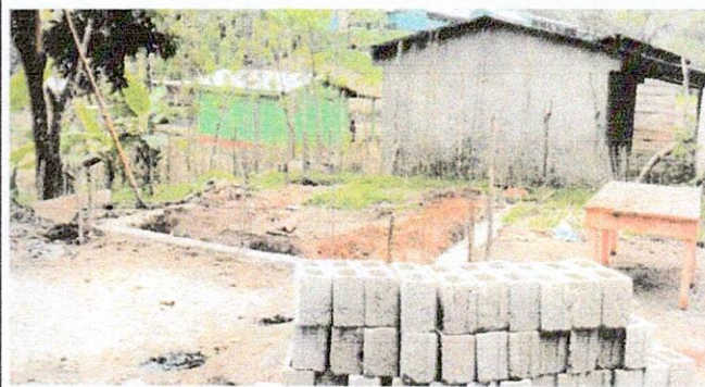
Foto 2: Mejoramiento de cocina tipo portico
